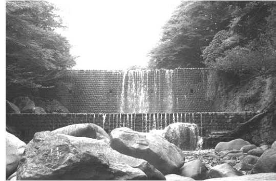
図-7 荒川第6堰堤下流面
