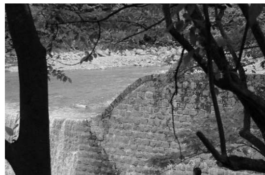
図-2 曲線が入った川上第1堰堤の袖部
