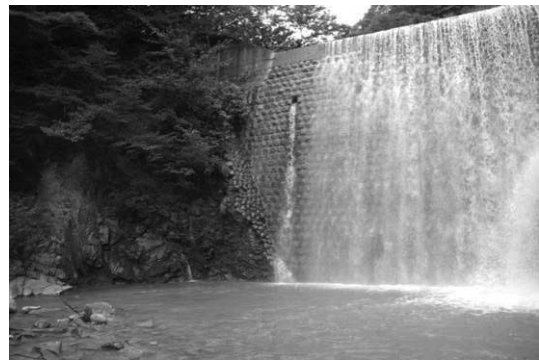
図-8 荒川第3堰堤下流面
